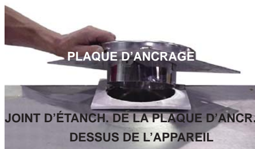
PLAQUE D'ANCRAGE POUR UNE CHEMINÉE PRÉFABRIQUÉE
